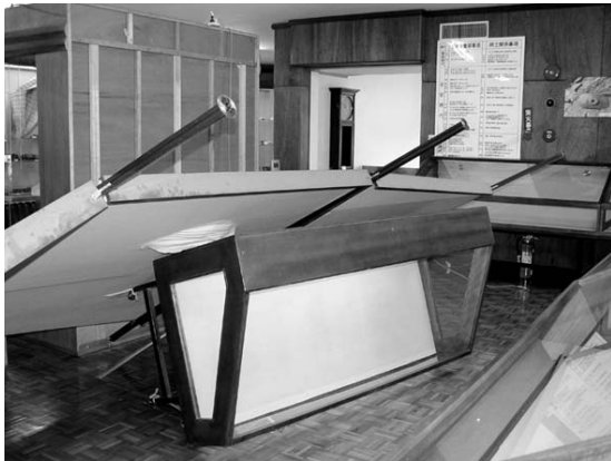
③仕切り壁及び展示ケースの転倒
