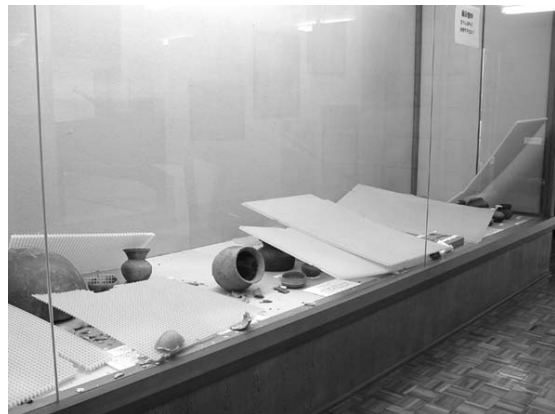
⑭ルーバーの落下(2)
