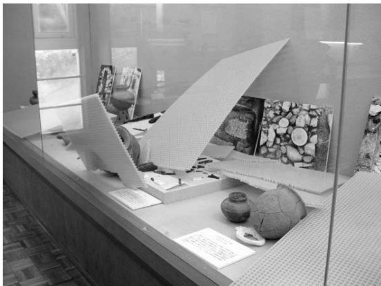
⑬ルーバーの落下(1)
