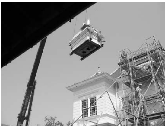
③クレーンによる煙突先行解体
