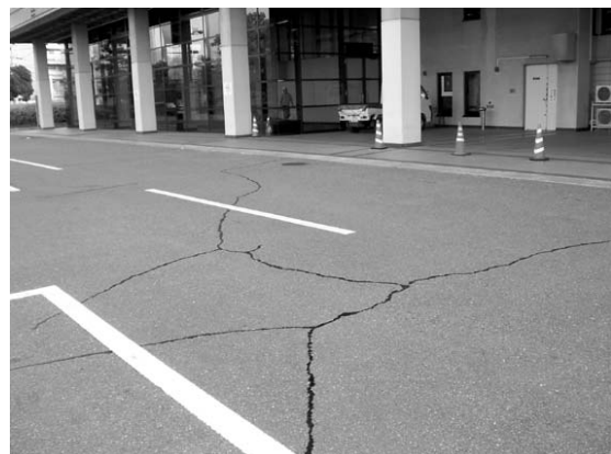
④駐車場の亀裂(補修後)
