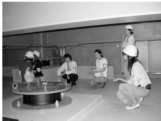
⑤免震ピット内部
