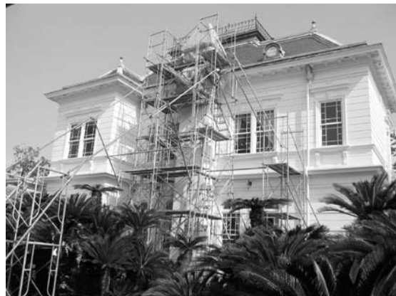
②西洋館 煙突崩落防止措置
