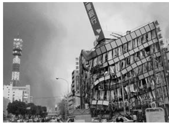
②ビルの倒壊現場
