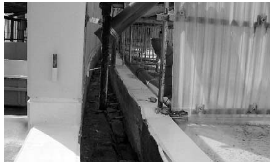
②アシカトレーニングヤード 壁面開き
