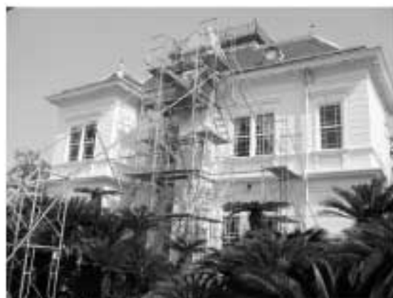
②西洋館 煙突崩落防止措置
