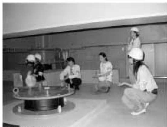
⑤免震ピット内部
