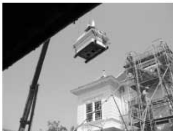
③クレーンによる煙突先行解体
